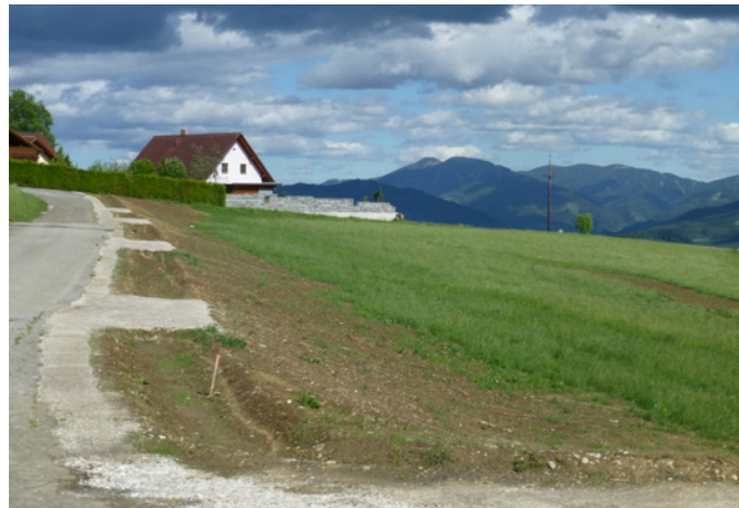
Bereits erfolgte Trinkwasseraufschließung in Kammern mit Trofaiacher Wasser
